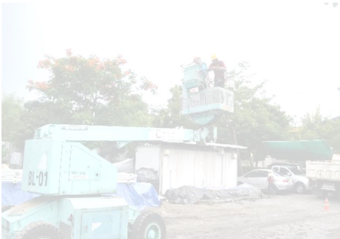
ภาพที่ ก-14 อบรมการใช้รถ X-lift และ Boom lift
