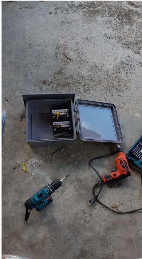
รูปที่ 5 ยึดแบตเตอรี่เข้ากับกล่อง
