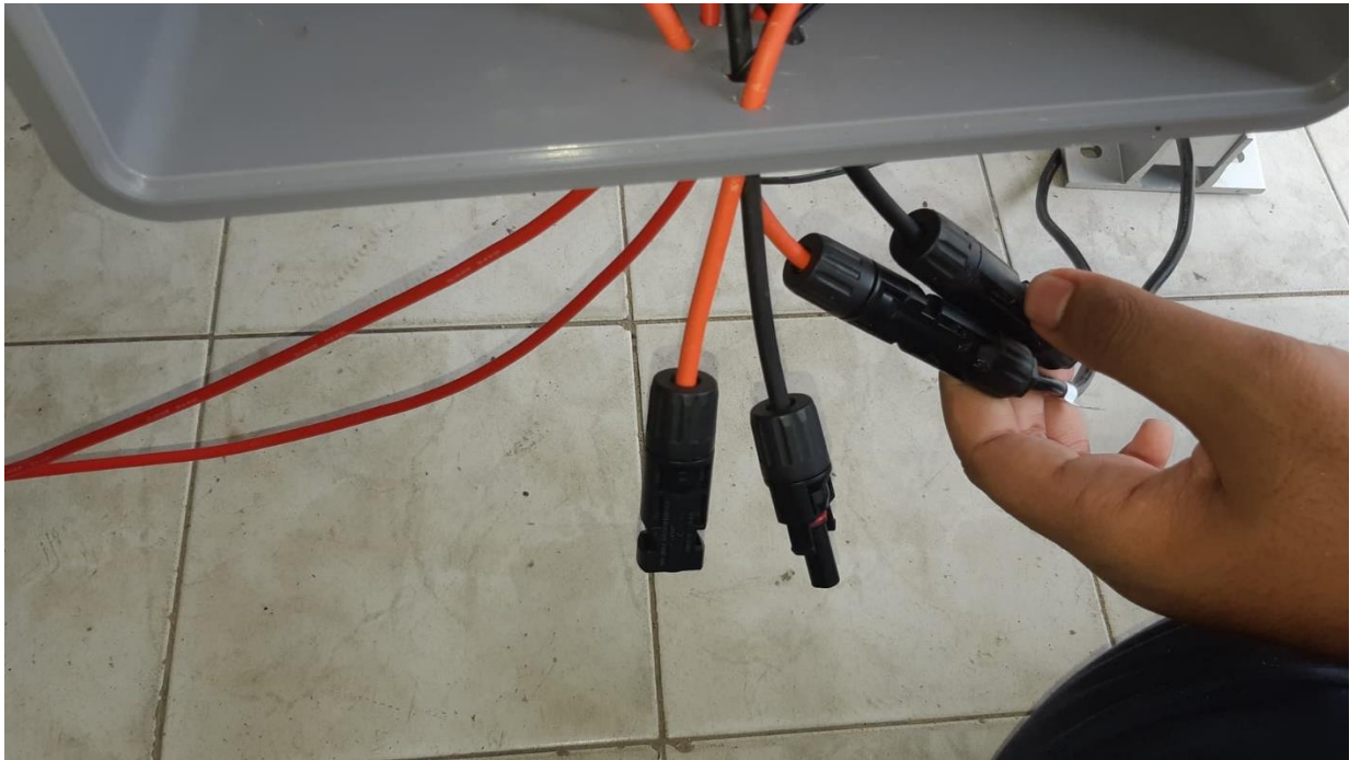
รูปที่ 2 ขั้นตอนที่ 2 เสียบสายป้อนกับสายโซล่าเซลล์
