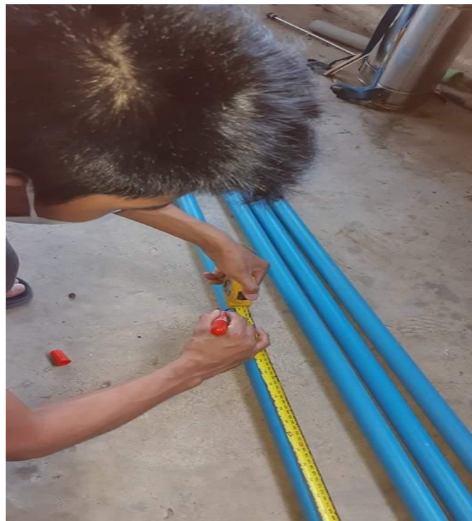
รูปที่ 2 วัดท่อและตัดท่อ
