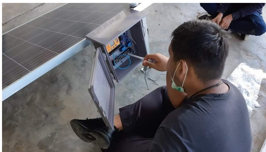
รูปที่ 4 ติดตั้งกล่อง แบตเตอรี่ และกล่องควบคุมพร้อมต่อวงจร กับแผงโซล่าเซลล์
