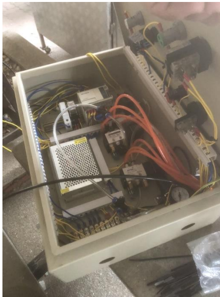
รูปที่ 10 เริ่มเก็บสายในตู้คอนโทรล
