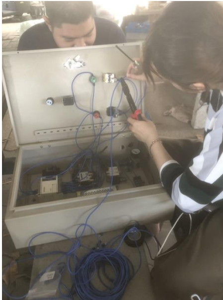
รูปที่ 7 เริ่ม wiring ตู้คอนโทรล
