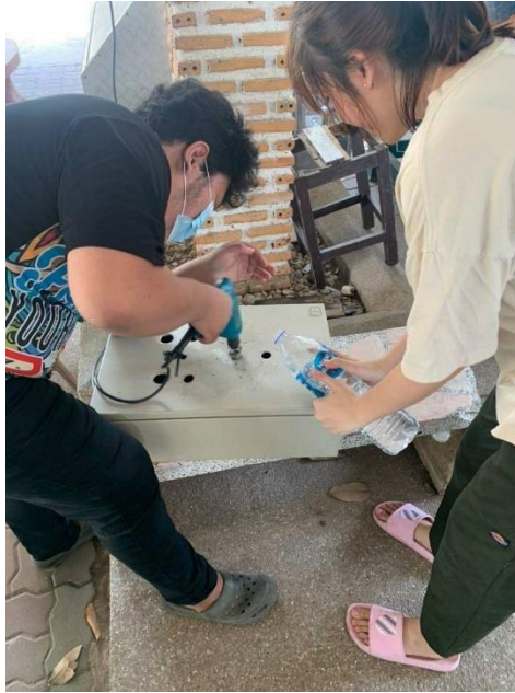
รูปที่ 3 เจาะรูเพื่อหลอดไฟแสดงสถานะหน้าตู้คอนโทรล
