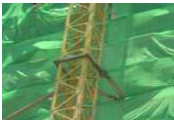
รูปที่ 8.5 สแลนกันฝุ่นและเศษวัสดุที่จะลอยออกไปทำความเดือดร้อนแก่บริเวณใกล้เคียงหน่วยงานก่อสร้าง
