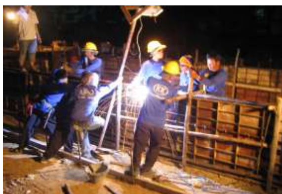
รูปที่ 8.15 การทำงานกลางคืนต้องอยู่ในเวลาที่ กำหนด ไม่รบกวนชุมชนรอบข้างและต้องมีแสง สว่างเพียงพอ
