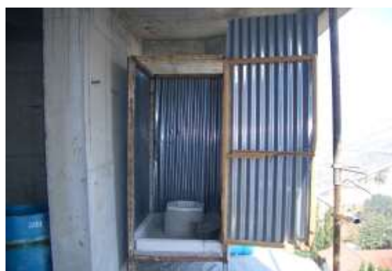
รูปที่ 8.16 ห้องน้ำชั่วคราวที่ใช้สำหรับคนงาน ควรใช้สุขภัณฑ์ที่ทำความสะอาดง่าย
