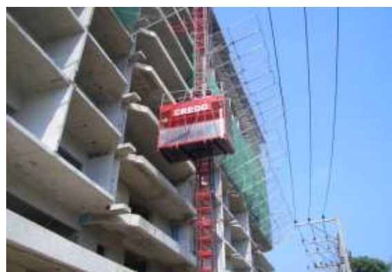
รูปที่ 8.6 ลิฟต์บรรทุกพนักงานและขนวัสดุต้องมีความมั่นคง และมีอุปกรณ์ให้ความปลอดภัย มีกฎระเบียบในการใช้
