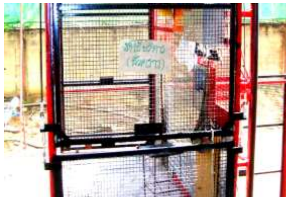
รูปที่ 8.8 ลิฟต์ที่ชำรุดต้องมีป้ายบอกเตือนหรือห้ามใช้งานเพราะอาจเกิดอันตรายขณะอยู่บนที่สูง
