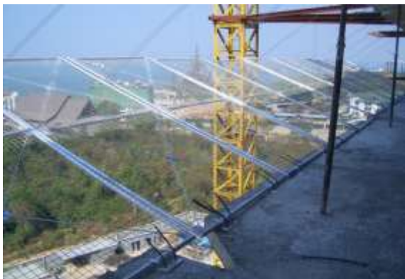
รูปที่ 8.7 แผงป้องกันพนักงานหรือวัสดุตกหล่นไปด้านล่าง ซึ่งอาจก่อให้เกิดอันตรายกับทรัพย์สินและบุคคลที่อยู่ด้านล่างได้
