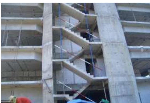
รูปที่ 8.9 ราวกันตกบริเวณบันไดที่ยังไม่ได้ทำ ราวบันไดถาวรภายนอกอาคาร เพื่อมิให้พนักงานตกลงไป
