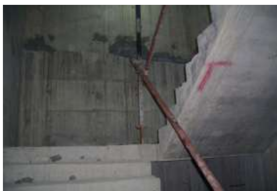
รูปที่ 8.10 ราวกันตกบริเวณบันไดภายในอาคาร
