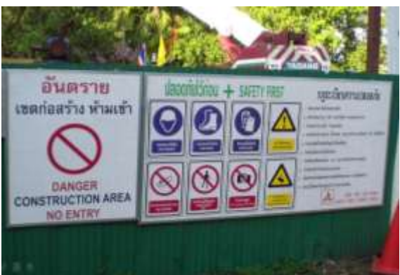
รูปที่ 8.11 การติดป้ายแสดงขอบเขตบริเวณพื้นที่ก่อสร้าง ซึ่งอาจเกิดอันตรายหากไม่ปฏิบัติตามกฎระเบียบของความปลอดภัยในงานก่อสร้าง
