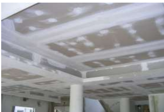
รูปที่ 7.87 การอุดและโป๊เพื่อปิดรอยต่อและรอยขีดข่วน
