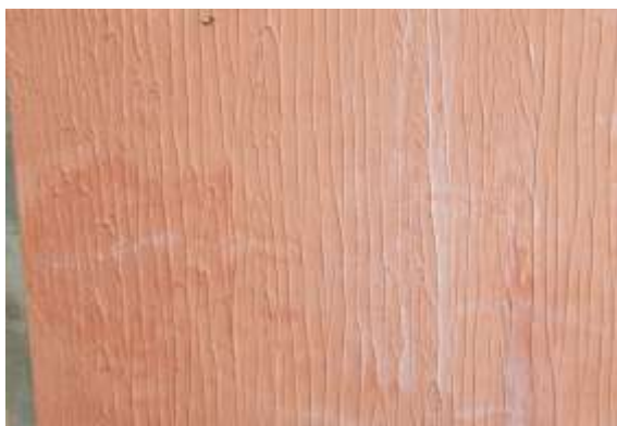
รูปที่ 7.69 การแต่งผิวปูนฉาบด้วยลูกกลิ้งทาสี (ตัวอย่างจากบริษัทผู้ผลิตปูนฉาบสำเร็จรูป)
