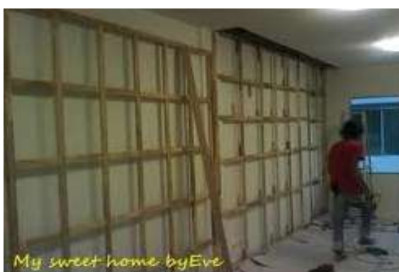
รูปที่ 7.45 การตั้งเคร่าไม้ยึดเพื่อติดตั้งผนังบอร์ด ต้องควบคุมให้มีการยึดให้มั่นคงกับโครงสร้างหลักและแบ่งช่องให้ถูกต้องลงตัวกับแผ่นบอร์ด อีกทั้งต้องได้แนวตั้งและระนาบก่อนอนุญาตให้ติดตั้งแผ่นบอร์ด
