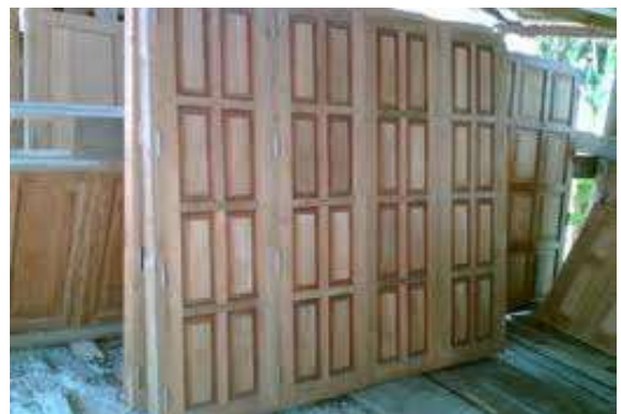
รูปที่ 7.82 บานเฟี้ยมเป็นที่นิยมใช้มานานจนถูก แทนที่ด้วยประตูเหล็กม้วน ปัจจุบันบานเฟี้ยมจะถูก ใช้เป็นฉากกั้นห้องประชุมและวัสดุที่ทำจะมีน้ำหนัก ไม่มาก เช่น อลูมิเนียม
