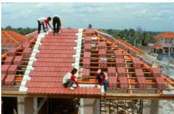
รูปที่ 7.137 การมุงวัสดุคลุมหลังคาบนแผ่นอลูมิเนียมกันความร้อน
