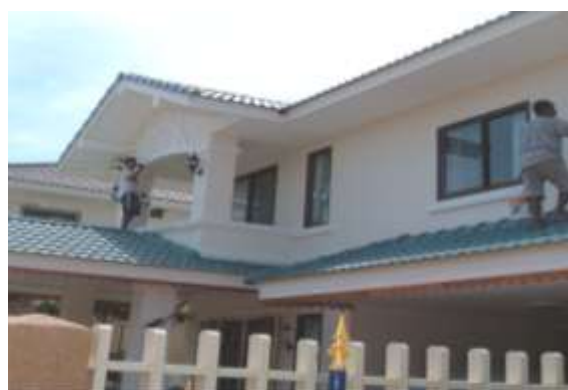
รูปที่ 7.106 การทาสีเก็บแต่งบัวรอบช่องเปิด ต่างๆ
