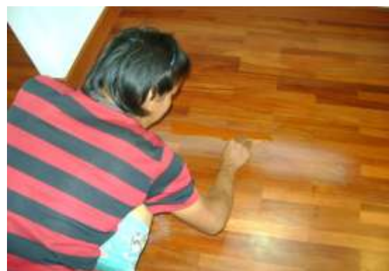
รูปที่ 7.14 การอุดแต่งผิวให้เรียบก่อนขัด
