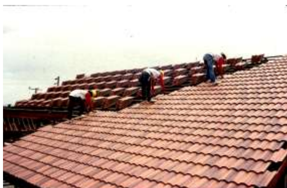
รูปที่ 7.133 การมุงวัสดุคลุมหลังคาประเภทแผ่นกระเบื้อง ช่างควรยืนในบริเวณที่เป็นโครงหลังคาเหล็กในขณะที่ทำงาน
