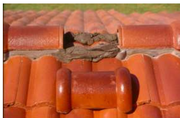
รูปที่ 7.140 การวางครอบสันหลังคาประเภทสองทาง
