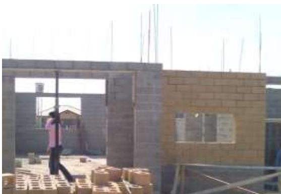
รูปที่ 7.43 การก่ออิฐรับแรง ซึ่งเป็นบ้านไม่มีเสาใช้อิฐในการรับแรง
