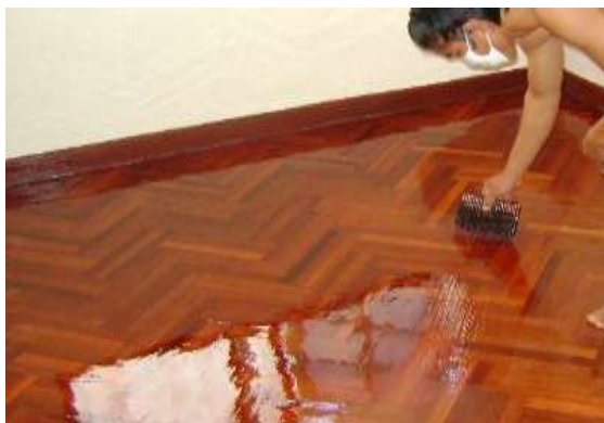
รูปที่ 7.107 การทาน้ำยาเคลือบเงาพื้น
