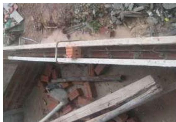
รูปที่ 7.38 การแสดงการทำเอ็นทับหลัง
