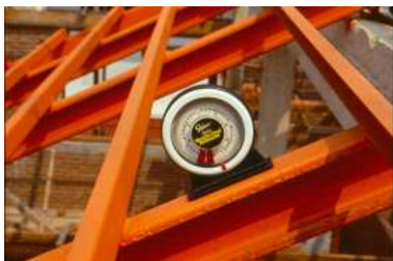
รูปที่ 7.127 ต้องมีการตรวจสอบความลาดเอียงของหลังคาว่าได้ตามแบบหรือไม่
