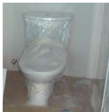
รูปที่ 7.122 เมื่อติดตั้งเสร็จทุกชั้นตอนแล้ว ต้องคลุมพลาสติกและติดด้วยเทปกาว เพื่อป้องกันรอยขีดข่วนก่อนส่งมอบงาน
