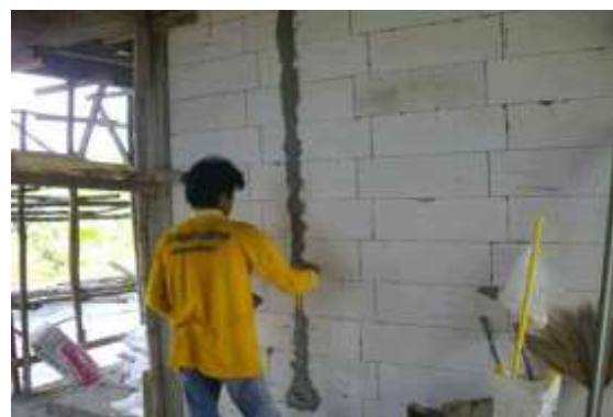
รูปที่ 7.62 การทำแนวฉาบปูนเพื่อควบคุมไม่ให้ผิวหน้าเป็นลูกคลื่น
