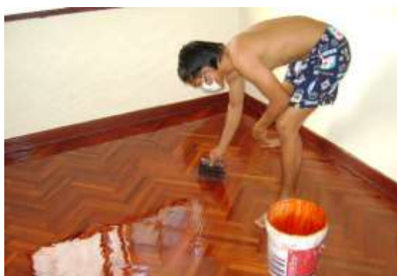
รูปที่ 7.15 การขัดสีผิวไม้และเคลือบเงา
