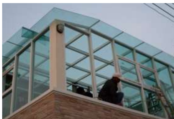
รูปที่ 7.92 การติดตั้งกระจกกรองแสงใช้เป็นหลังคา
