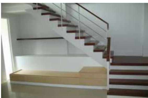
รูปที่ 7.111 บันไดคอนกรีตปูทับลูกนอนด้วยไม้
