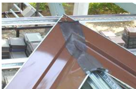
รูปที่ 7.145 บริเวณรอยต่อระหว่างตะเข้รางสองแนวจบกัน ต้องปิดรอยต่อด้วยแผ่นกันซึม
