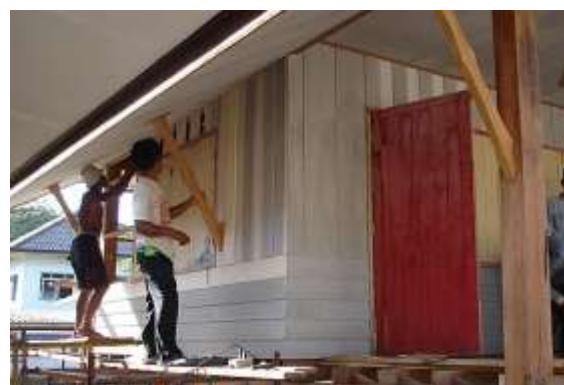
รูปที่ 7.52 การตีฝาด้านล่างเป็นแบบซ้อนเกร็ด ด้านบนเป็นแบบทับแนว ที่ทำเสร็จเรียบร้อย
