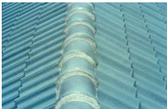
รูปที่ 7.143 การยาแนวครอบสันหลังคา แต่ไม่ทาสีทำให้มองดูไม่สวยงาม
