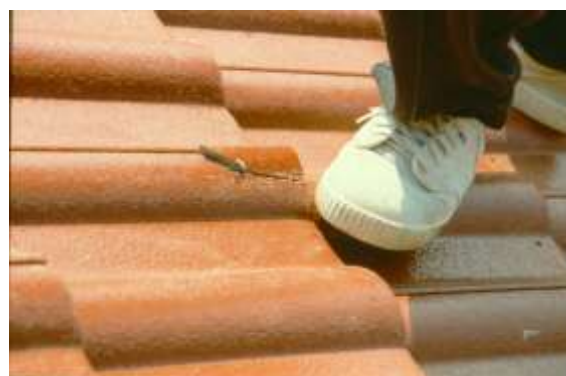
รูปที่ 7.134 การเดินบนวัสดุคลุมหลังคา ที่ไม่เดินเดินตามแนวโครงเหล็ก จึงทำให้วัสดุคลุมเกิดความเสียหาย
