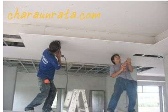
รูปที่ 7.84 การติดตั้งฝ้าแบบไล่ระดับภายในอาคาร
