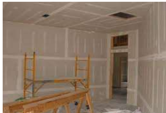
รูปที่ 7.48 การติดตั้งรอยต่อและรอยตำหนิหรือรอยขีดข่วนของแผ่นบอร์ดที่นำมาทำผนัง
