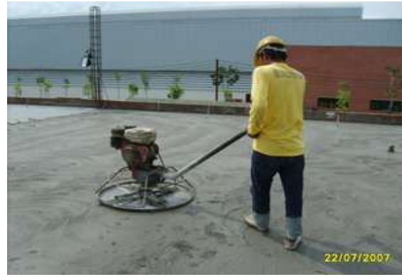
รูปที่ 7.28 ขัดปรับระดับให้ผิวเรียบเสมอกัน ด้วยเครื่องขัด
