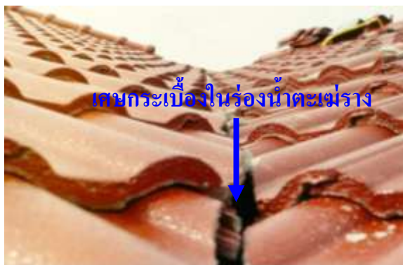
รูปที่ 7.147 ตรวจสอบเศษวัสดุและเศษปูนมิให้ ขวางทางน้ำในร่องน้ำตะเหมียง
