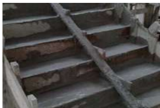
รูปที่ 7.110 การเทคอนกรีตบันไดควบคุมและตรวจงานโครงสร้างในหน่วยที่ 4
