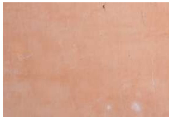
รูปที่ 7.70 การแต่งผิวปูนฉาบแบบใช้เกียงปาดเรียบกึ่งขัดมันด้วยปูนสี (ตัวอย่างจากบริษัทผู้ผลิตปูนฉาบสำเร็จรูป)
