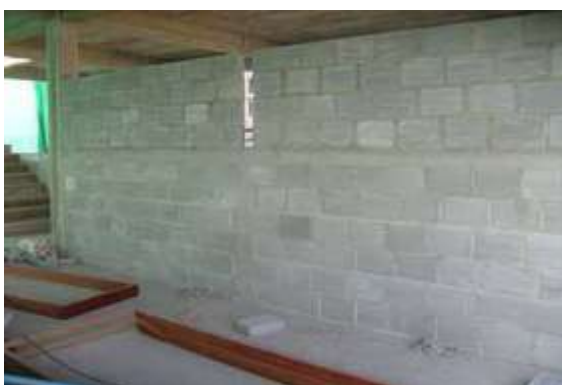
รูปที่ 7.41 การก่ออิฐบล็อก
