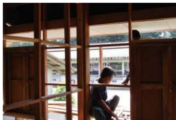
รูปที่ 7.50 การติดตั้งวงกบประตูไม้จริง
