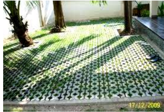
รูปที่ 7.22 บล็อกปลูกหญ้าที่ปูเสร็จเรียบร้อยแล้ว
