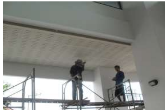
รูปที่ 7.86 การติดตั้งฝ้าภายนอกอาคาร
