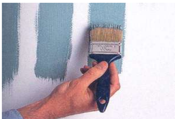
รูปที่ 7.99 การทาสีโดยใช้แปรงทาสี
