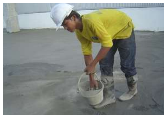
รูปที่ 7.26 หลังจากเทปูนปรับระดับแล้วต้องโรยปูนซีเมนต์ผงหรือสารเคมีประเภทเคลือบผิวให้กระจายทั่วกัน โดยสม่ำเสมอ
