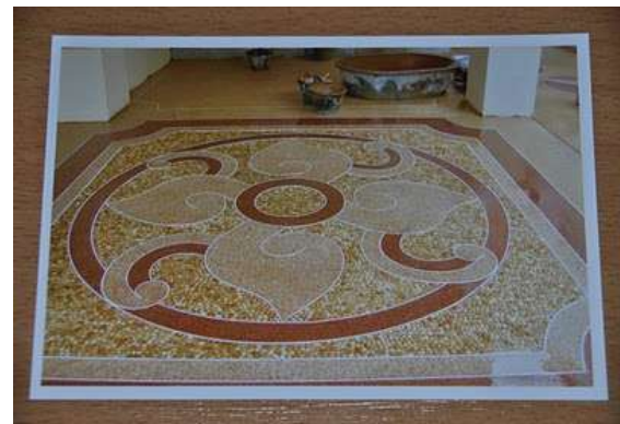
รูปที่ 7.10 การปูหินขัดภายในอาคารแบบ ตกแต่งลวดลาย
