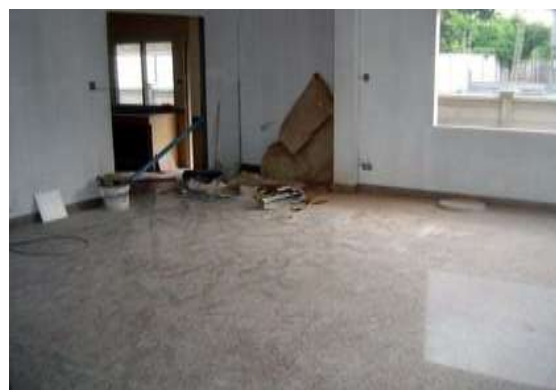
รูปที่ 7.6 การปูหินแกรนิตพื้นอาคาร
