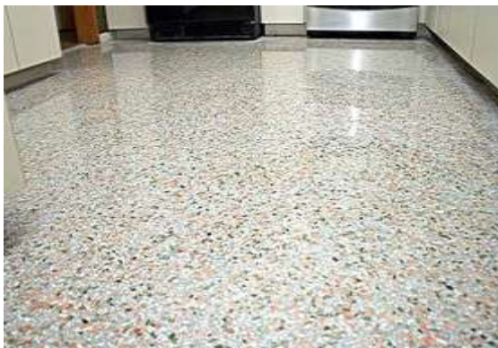
รูปที่ 7.9 การปูหินขัดภายในอาคารแบบ ลวดลายแบบเดี่ยวตลอดทั้งห้อง
