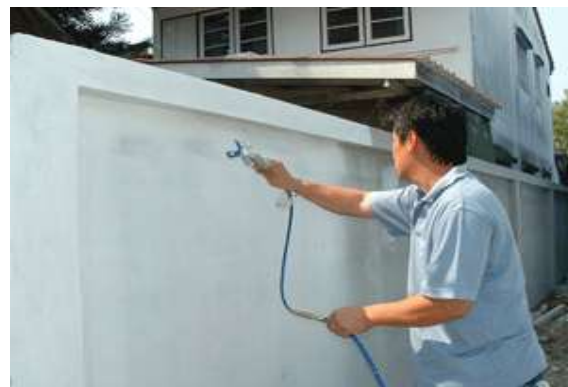
รูปที่ 7.102 การใช้วิธีพ่นสีน้ำพลาสติกแทน การทาสี
