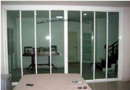
รูปที่ 7.79 บานยูพีวีซีมีลักษณะการใช้งาน เหมือนอลูมิเนียม
