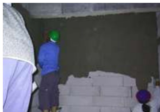
รูปที่ 7.64 การฉาบปูนผนังก่ออิฐมวลเบาต้องใช้อุปกรณ์สำหรับฉาบผนังมวลเบา
