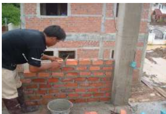
รูปที่ 7.37 การก่ออิฐมอญต้องเกาะให้อิฐแต่ละก้อนมีระดับหลังอิฐเท่ากัน
