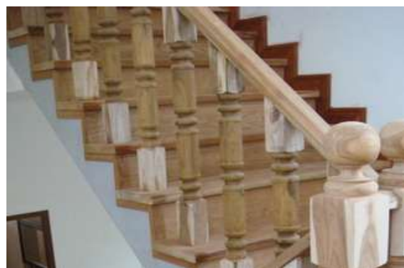
รูปที่ 7.114 บันได ลูกกรง ราวบันได เสารับ ราวบันไดทำจากไม้ทั้งหมด
