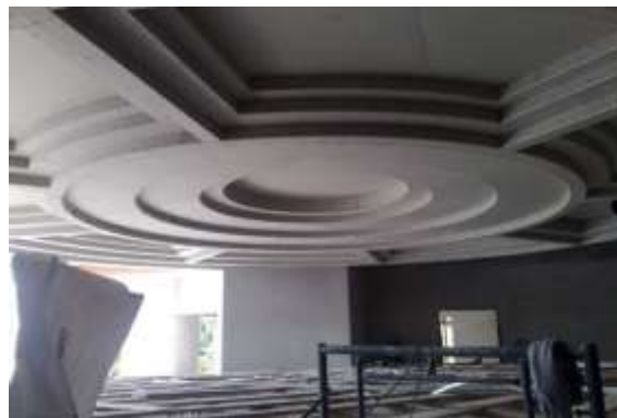
รูปที่ 7.90 การตกแต่งฝ้าเพดานเล่นระดับเป็น ลวดลาย ซับซ้อนหลายชั้น ด้วยวัสดุประเภทบอร์ด ที่สามารถตัดโค้งได้
