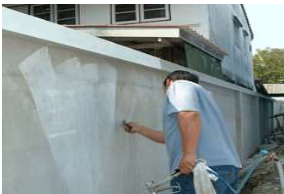
รูปที่ 7.101 ก่อนลงมือทาสีหรือพ่นสีต้องใช้ เกียงไปวสีชุดแต่งผิวพื้นที่จะทำให้เรียบ
