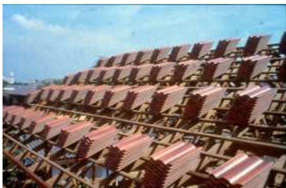
รูปที่ 7.131 การจัดเรียงกระเบื้องเพื่อกระจายน้ำหนักทางแนวตั้งตามกรรมวิธีของผู้ผลิต
