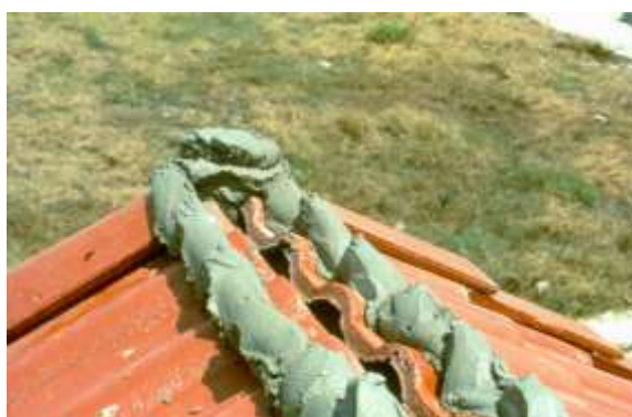
รูปที่ 7.139 การวางปูนทรายเพื่อวางครอบสันหลังคา
