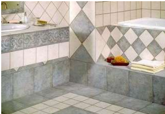
รูปที่ 7.1 การจัดลวดลายปูกระเบื้องพื้น
