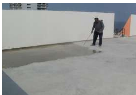
รูปที่ 7.36 พื้นปูนขัดมันกันซึม ขณะกำลังฉีดน้ำยาบ่มผิว
