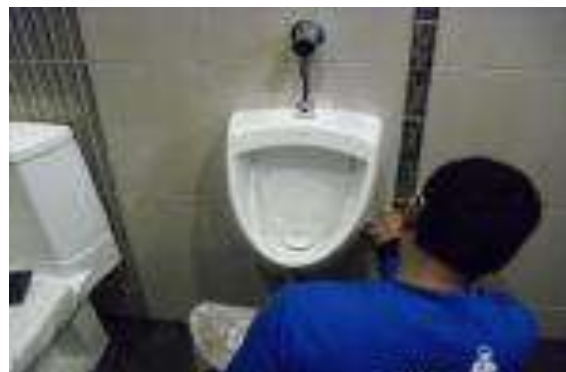
รูปที่ 7.120 การติดตั้งโถปัสสาวะชั้นตอนสุดท้าย ต้องเชื่อมต่อระหว่างผนังกับตัวสุขภัณฑ์
