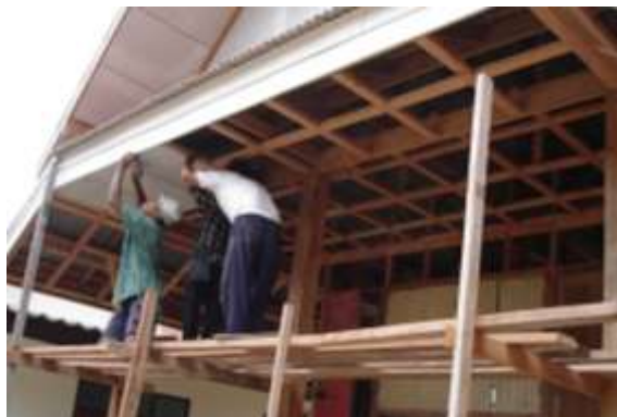
รูปที่ 7.89 การวางโครงคร่าวไม้เพื่อติดตั้งฝ้า
