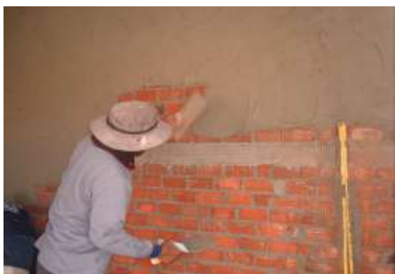
รูปที่ 7.63 การฉาบปูนผนังก่ออิฐมวลเบา
