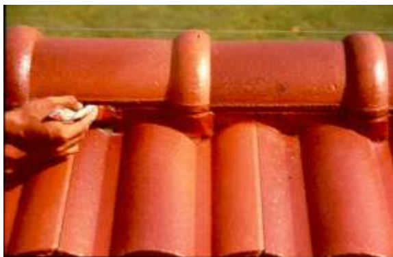
รูปที่ 7.141 การทาสีเก็บรายละเอียดครอบสันหลังคา
