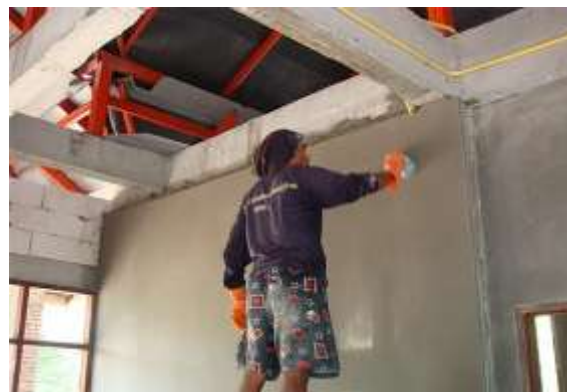
รูปที่ 7.66 การปั้นหน้าปูนให้เรียบด้วยเกียงโบกปูน
