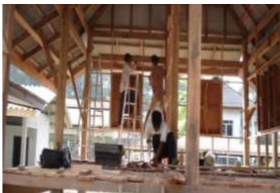
รูปที่ 7.49 การติดตั้งวงกบประตูหน้าต่างยึดกับคร่าไม้ที่สำหรับติดตั้งฝาไม้หรือฝาไม้
