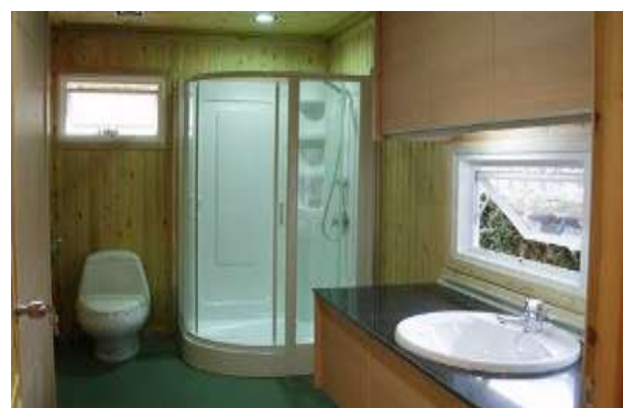
รูปที่ 7.124 การติดตั้งตู้อ่างน้ำ กระจกต้องเป็นกระจกนิรภัย
