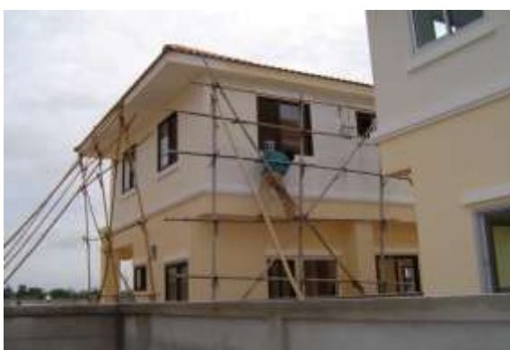
รูปที่ 7.105 การตั้งนั่งร้านทาสีภายนอกอาคาร
