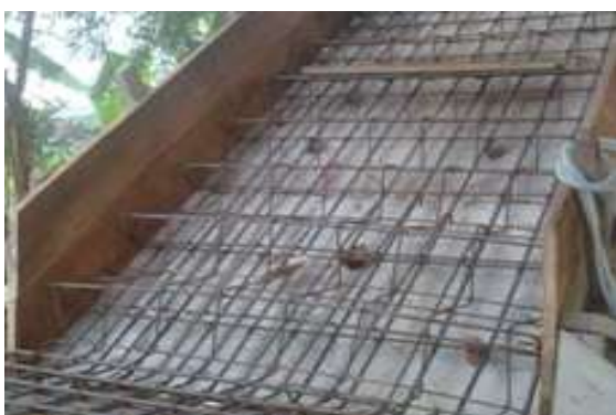
รูปที่ 7.109 การผูกเหล็กโครงสร้างบันไดคอนกรีตให้ควบคุมและตรวจตามงานโครงสร้างในหน่วย 4
