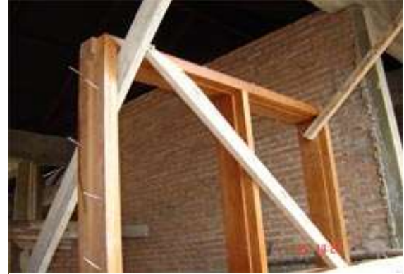
รูปที่ 7.72 การตั้งวงกบหน้าต่างยึดไว้ให้มั่นคงก่อนการเทเอ็นคอนกรีตยึดข้างวงกบ
