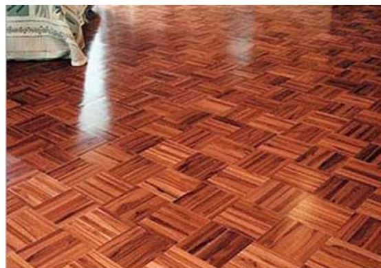
รูปที่ 7.108 หลังจากลงน้ำยาเคลือบเงาเสร็จ ต้องรอให้น้ำยาแห้งตามข้อกำหนดของผู้ผลิต จึงจะเข้าทำการใช้สอยพื้นที่ได้
