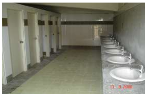
รูปที่ 7.123 การติดตั้งอ่างล้างหน้าและก๊อกร่างในห้องน้ำรวม
