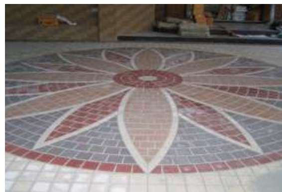
รูปที่ 7.4 การจัดลวดลายปูกระเบื้องที่สลับบัซซันต้องควบคุมและตรวจให้ถูกต้องตาม Shop Drowning ที่ได้รับอนุมัติไว้
