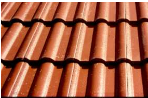
รูปที่ 7.135 การวางวัสดุคลุมหลังคาที่ผิด รอยต่อตรงกันจะทำให้หลังคารั่ว
