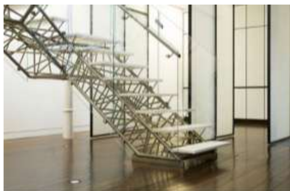
รูปที่ 7.113 บันไดเหล็กตัดลวดลายภายในอาคาร
