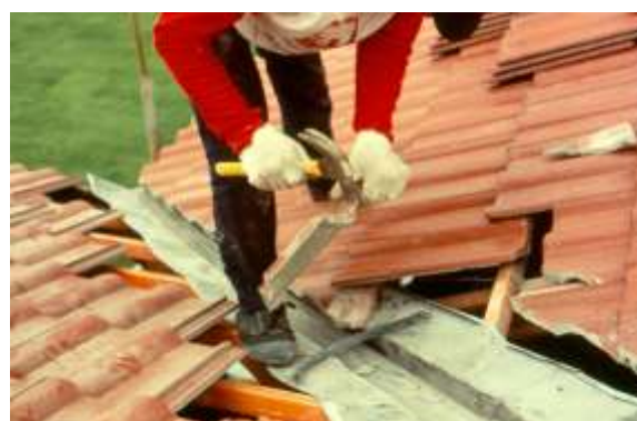
รูปที่ 7.146 ต้องควบคุมมิให้คนเดินในบริเวณรางระบายน้ำ มิฉะนั้นอาจจะทำให้รางน้ำเสียหายดังภาพ
