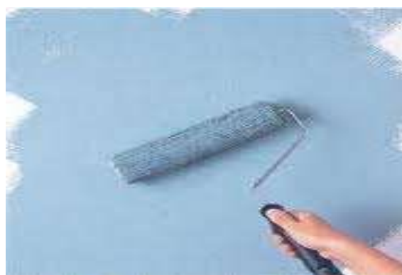
รูปที่ 7.98 การทาสีโดยใช้ลูกกลิ้งทาสี
