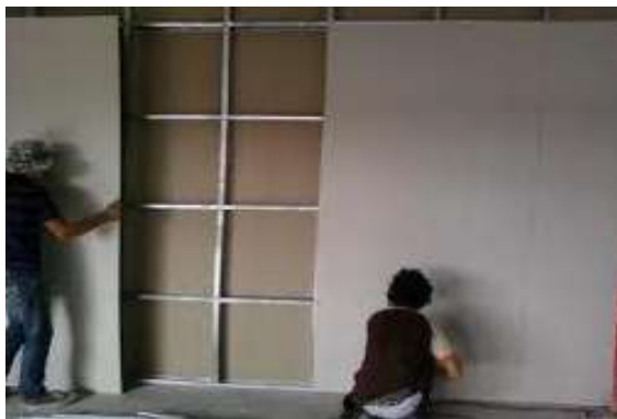
รูปที่ 7.47 การติดตั้งผนังวัสดุบอร์ดที่ใช้ทำผนังยึดติดกับโครงเหล็ก
