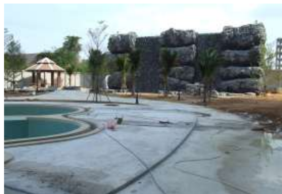
รูปที่ 7.58 การเตรียมพื้นที่ผิวพื้นทำทรายล้างต้องสะอาด ไม่มีสิ่งปิดผิวพื้นคอนกรีต ปูนซีเมนต์ที่ทำทรายล้างสามารถยึดติดกับพื้นที่รองรับได้มั่นคง
