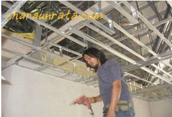
รูปที่ 7.83 การวางโครงคร่าวอลูมิเนียมเพื่อติดตั้งฝ้าประเภทบอร์ดซึ่งเป็นวัสดุเบา
