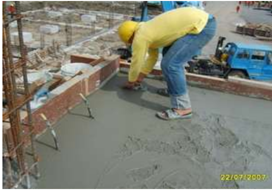
รูปที่ 7.27 ในกรณีที่ขัดด้วยเครื่องตามมุมต่างๆ ที่เครื่องเข้าไม่ถึง ต้องใช้ช่างฝีมือดำเนินการ
