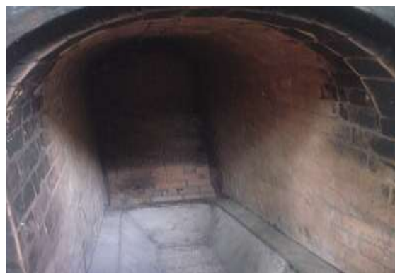
รูปที่ 7.44 การก่ออิฐทไฟในเมรุเผาศพ
