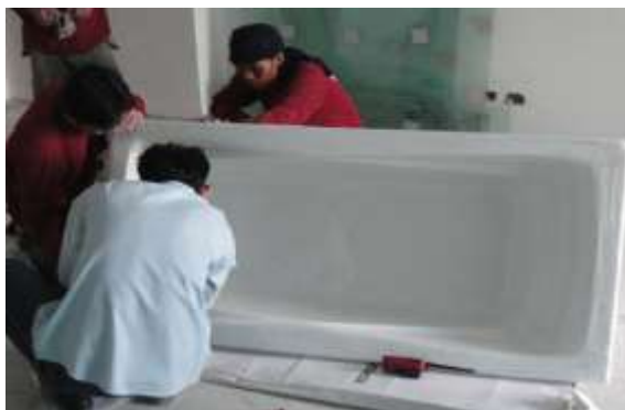
รูปที่ 7.119 การประกอบอุปกรณ์อ่างอาบน้ำ ก่อนติดตั้งอ่างและยึดให้มั่นคง
