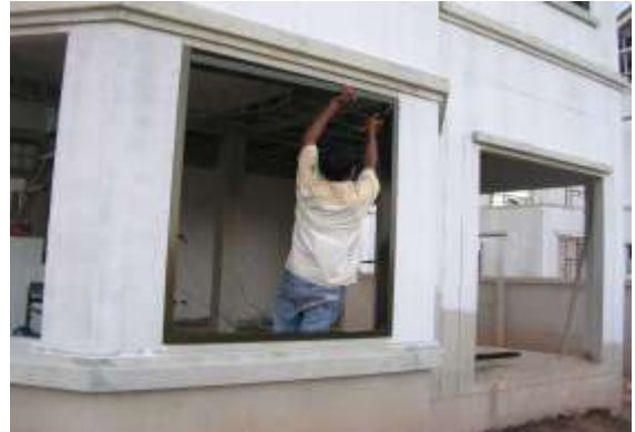
รูปที่ 7.74 การจับขอบปูนสำหรับการติดตั้งวงกบและบานอลูมิเนียม
