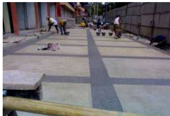
รูปที่ 7.24 การปูบล็อกจัดลาดสายสีลานหน้าอาคาร
