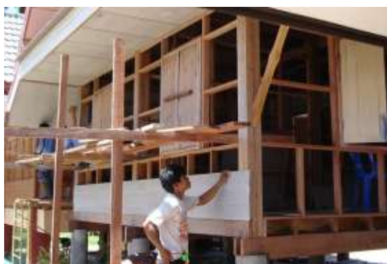
รูปที่ 7.51 คร่าไม้จริง ไม้ฝาเป็นไม้เซอร่า ส่วนใตหน้าต่างเป็นการวางคร่าตีฝาไม้สำหรับซ้อนเกร็ด ด้านบนเป็นการวางคร่าสำหรับติดตั้งฝาแบบทับแนว
