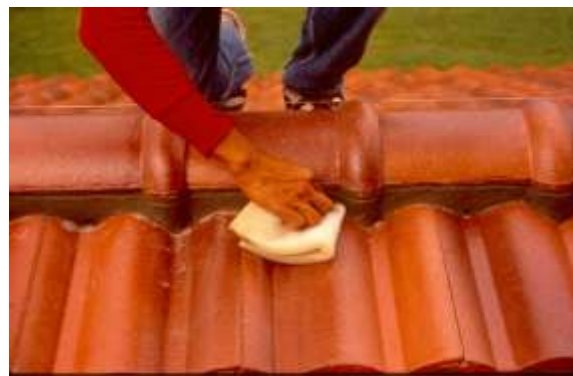
รูปที่ 7.142 ต้องทำความสะอาดหลังจากใส่ครอบสันหลังคา
