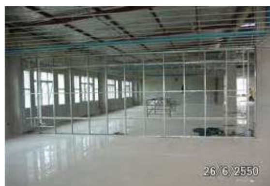
รูปที่ 7.46 การวางเคร่าเหล็กซี่ลาย สำหรับเป็นเคร่ายึดผนัง มีการควบคุมและตรวจสอบหลักการเดียวกับเคร่าไม้
