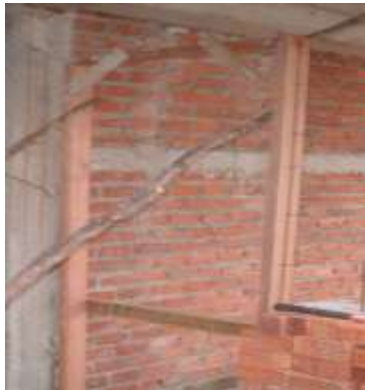
รูปที่ 7.73 แสดงร่องข้างวงกบที่มีตะปูตีโผล่หัวไว้สำหรับยึดติดกับเอ็นคอนกรีต
