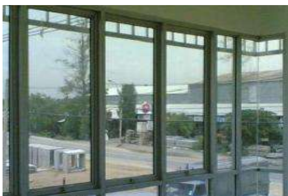
รูปที่ 7.91 การติดตั้งกระจกช่องหน้าต่างบานอลูมิเนียม
