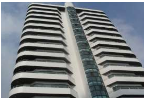
รูปที่ 7.81 ช่องแสงปิดตายและบานกระทุ้ง บริเวณบันไดของอาคารสูง ช่วยเพิ่มความสว่าง งานให้อาคาร
