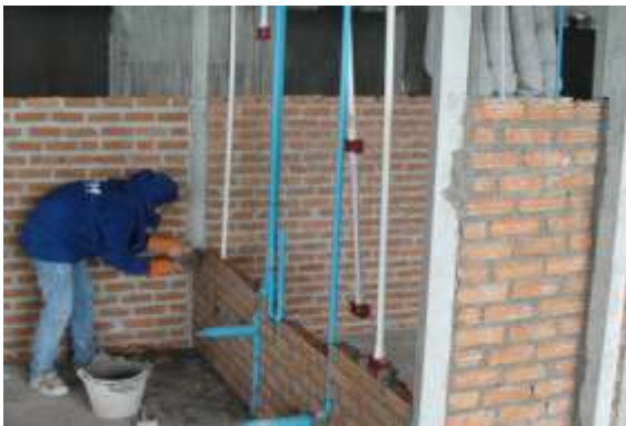
รูปที่ 7.39 การเดินท่อน้ำและท่ออิฐปิดทับท่อน้ำ
