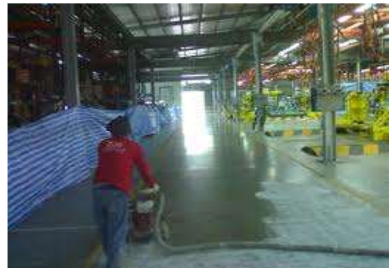
รูปที่ 7.30 การขัดมันผิวฟลอร์ฮาร์ดดินเคอร์
