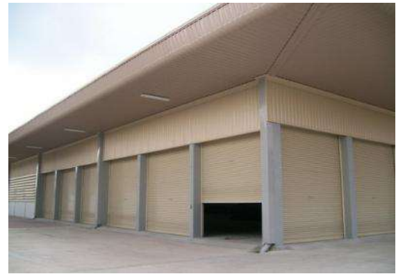
รูปที่ 7.78 ประตูบานม้วน มีประโยชน์ทำให้ ไม่เปลืองเนื้อที่ ใช้สอยเวลาเปิด-ปิด
