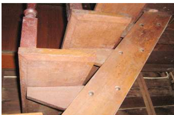
รูปที่ 7.115 บันไดไม้ แสดงการยึดพุกติดแม่บันไดน็อค
