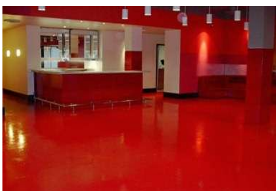
รูปที่ 7.35 พื้นผิวเคลือบฟลอซาร์ดดินเนอร์
