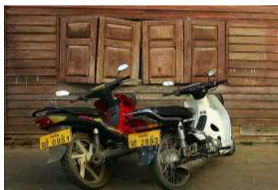
รูปที่ 7.54 ฝาไม้จริง ซึ่งในปัจจุบันไม่เป็นที่นิยมแล้ว เนื่องจากหาไม้ซอมแซมปรับปรุงยากเพราะราคาสูงและยังต้องมีการบำรุงรักษาเพื่อป้องกันแมลงกัดกิน เช่น การทาน้ำมันหรือสีเคลือบผิวหากไม่ทำจะมีสภาพทรุดโทรม
