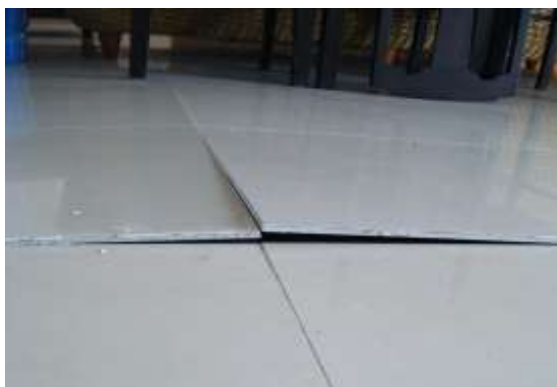
รูปที่ 7.3 การปูกระเบื้องที่วัสดุยึดใต้ห้องกระเบื้องไม่เต็มแผ่น เช่น ตามมุมกระเบื้อง เมื่อน้ำหนักมากลงมุมใดมุมหนึ่ง ทำให้กระเบื้องหลุดและมุมด้านตรงข้ามลอยขึ้น
