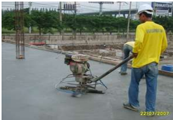
รูปที่ 7.29 หลังจากทิ้งระยะเวลาให้ผิวสามารถ ขัดมันได้ใช้เครื่องขัดมัน โดยเปลี่ยนใบเป็น แบบใบพัด
