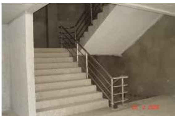
รูปที่ 7.117 บันไดคอนกรีต ราวบันไดสแตนเลส ป้องกันการขีดขีดโดยการหุ้มพลาสติกบางๆ
