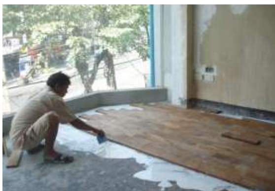
รูปที่ 7.13 ปูพื้นไม้ปาเก้โดยใช้กาวเป็นตัวเชื่อมประสานให้ติดกับพื้น โครงสร้าง
