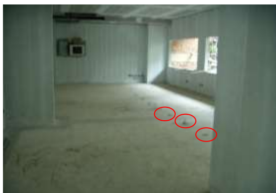
รูปที่ 7.25 การตีค้ำปูระดับเพื่อเทบดแต่งผิวพื้นให้ได้ระดับ
