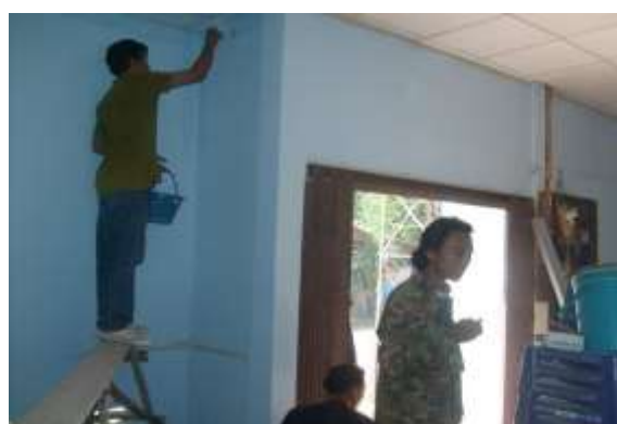
รูปที่ 7.104 การทาสีทับหน้าให้ครบจำนวนครั้ง จะต้องให้สีสม่ำเสมอทั้งพื้นที่ทา
