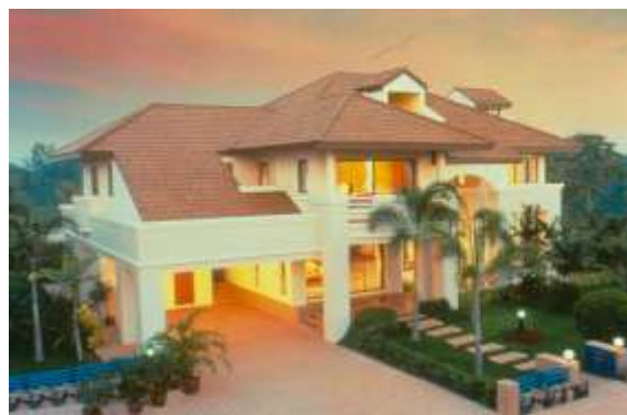
รูปที่ 7.148 การมุงวัสดุหลังคาเสร็จเรียบร้อย แล้วมีความสวยงาม
