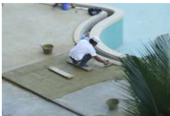
รูปที่ 7.59 ช่างทำทรายล้างกำลังปรับระดับผิวทรายล้างให้ได้ระดับและเม็ดทรายหรือเม็ดหินเรียงตัวกันสม่ำเสมอ
