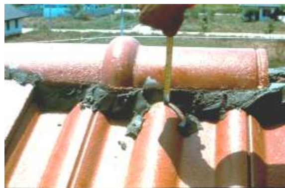
รูปที่ 7.138 ต้องมีการใช้ระดับหึงครอบสันหลังคาต้องได้ระดับเท่ากันทุกอัน
