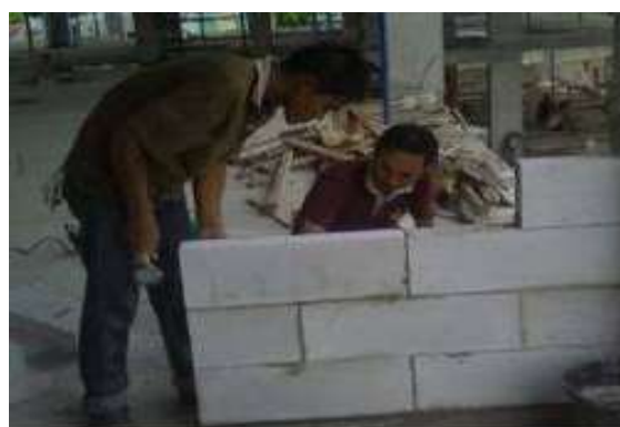
รูปที่ 7.42 การก่ออิฐมวลเบา ซึ่งจะต้องใช้ปูนก่อเฉพาะ
