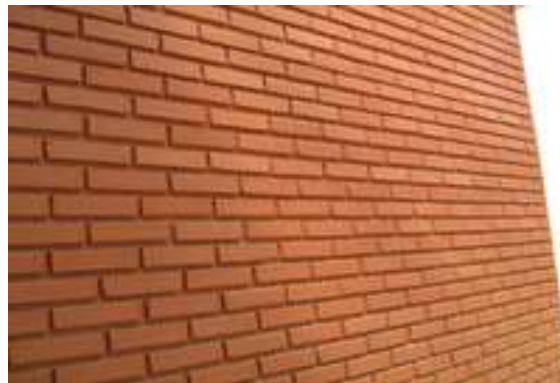
รูปที่ 7.40 การก่ออิฐโชว์แนว
