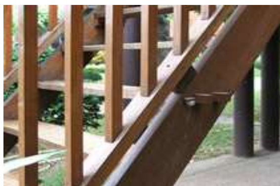
รูปที่ 7.118 บันไดไม้ชนิดฝึกลูกนอนในแม่บันได ไม่มีลูกตั้ง
