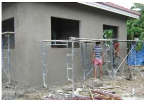
รูปที่ 7.67 การฉาบภายนอกที่เสร็จเรียบร้อยแล้ว
