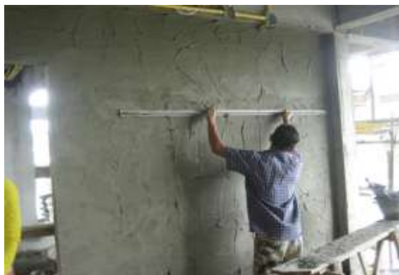
รูปที่ 7.65 การเดินเกียงบรรทัดปรับผิวไม้ให้เป็นลูกคลื่น
