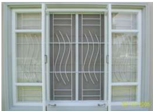
รูปที่ 6.13 หน้าต่างลูกกรงเหล็กตัดพร้อมมี บานมุ้งลวดอลูมิเนียม
