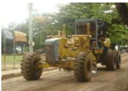
รูปที่ 6.44 การปรับผิวถนนด้วยเครื่องจักรกลงานก่อสร้าง
