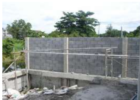
รูปที่ 6.59 การทำเขื่อนริมน้ำ พร้อมทำ กำแพงหลังเขื่อน ก่อนถมดิน
