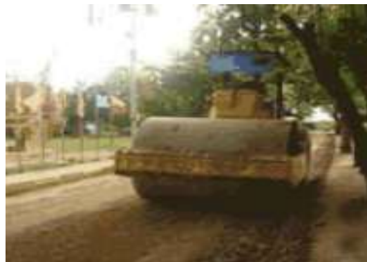
รูปที่ 6.45 การบดอัดดินชั้นรองรับผิวจราจรด้วยเครื่องจักรกลงานก่อสร้าง
