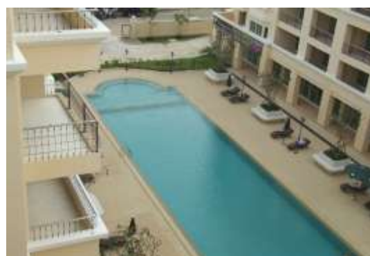
รูปที่ 6.33 สระน้ำที่ก่อสร้างเสร็จเรียบร้อยแล้ว
