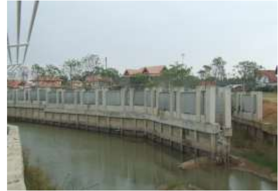
รูปที่ 6.63 เขื่อนกั้นดินริมน้ำที่มีรั้วตั้งอยู่บนหลังเขื่อน
