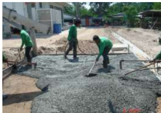
รูปที่ 6.51 การเทคอนกรีตลงบนพื้นถนนต้องเทให้คอนกรีต
