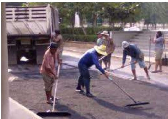
รูปที่ 6.46 การเกลี่ยผิวแอสฟัลต์ด้วย แรงงานคน
