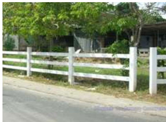
รูปที่ 6.4 รั้วประเภทคอกสัตว์เลี้ยง เช่น ม้า ต้องควบคุมให้แผ่นรั้วแนวนอนได้ระดับ
