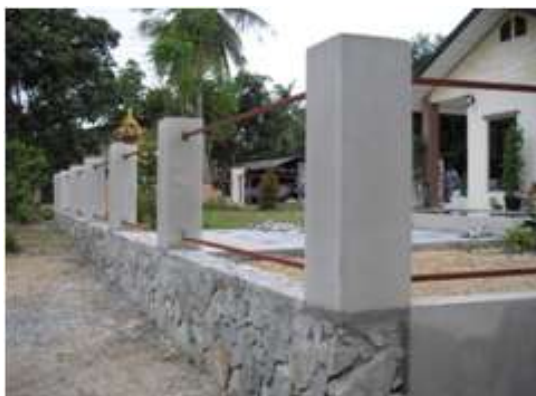
รูปที่ 6.1 เสารั้วที่มีการฉาบหรือตกแต่งและวางคร่าวสำหรับรับแผงรั้ว
