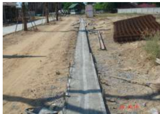
รูปที่ 6.57 รางระบายน้ำคอนกรีตต้องตรงไม่ คดและมีความลาดเอียงไปยังบ่อพักตามที่ ออกแบบไว้
