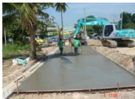
รูปที่ 6.53 ต้องตรวจสอบผิวหน้าคอนกรีตให้มีความสม่ำเสมอ
