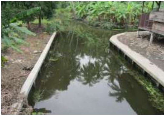
รูปที่ 6.60 เขื่อนริมน้ำที่ใช้เสาเข็มและแผงกั้นดินเป็นแนวตั้ง
