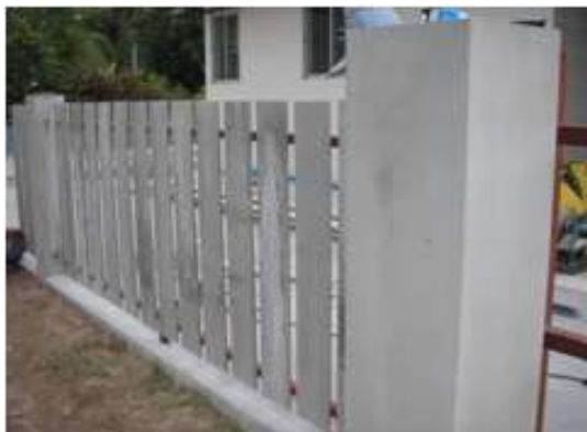
รูปที่ 6.3 แสดงการเว้นช่องแผ่นรั้วที่เท่ากัน ได้แนวตั้งและระดับแผ่นรั้วเท่ากันทุกแผ่น
