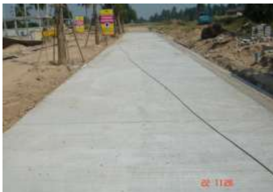
รูปที่ 6.56 ถนนคอนกรีตที่สามารถใช้งาน หลังจากการบ่มคอนกรีต
