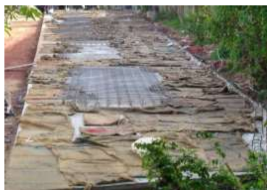
รูปที่ 6.55 ผิวถนนหลังจากคอนกรีตเซตตัวควรต้องมีการบ่มคอนกรีต ซึ่งมีหลายวิธี เช่น การขังน้ำ พ่นน้ำยาเคลือบผิว แต่ในภาพเลือกวิธีใช้กระสอบคลุมและฉีดด้วยน้ำ
