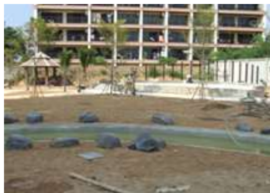
รูปที่ 6.21 การปรับพื้นที่และจัดทำหินเทียมในงานภูมิสถาปัตยกรรมของอาคารขนาดใหญ่
