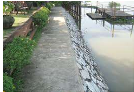
รูปที่ 6.61 เขื่อนลาดด้วยหินทำมุมเอียงเพื่อถ่ายน้ำหนักของแรงดันดิน
