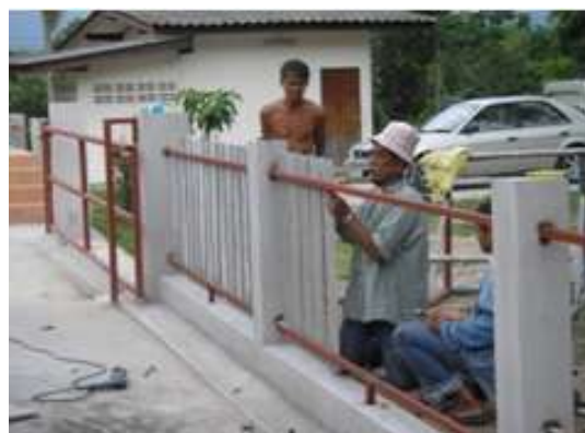
รูปที่ 6.2 แสดงการยึดแผ่นรั้วติดกับคร่าว ต้องควบคุมให้เว้นระยะห่างเท่ากัน ต้องได้คิงและระดับ
