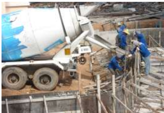
รูปที่ 6.30 การเทคอนกรีตขอบสระน้ำ
