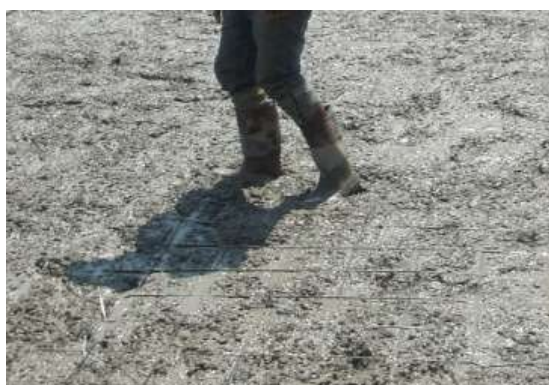
รูปที่ 6.52 แสดงการเหยียบเหล็กเสริมคอนกรีตให้จมลงไปในผิวหน้าตามระยะความลึกที่กำหนด
