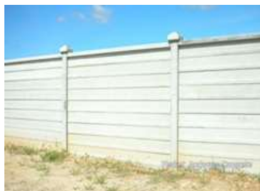
รูปที่ 6.6 รั้วคอนกรีตสำเร็จรูปต้องเช็คให้ได้ ตั้งและแนว
