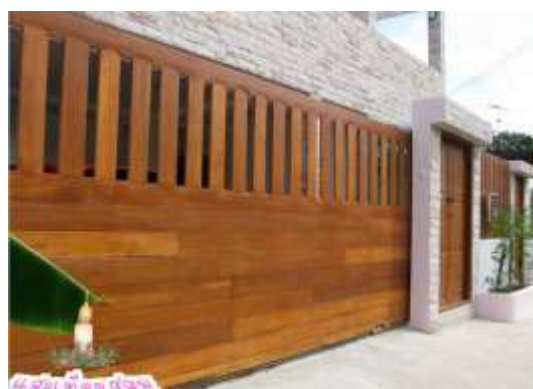
รูปที่ 6.12 ประตูรั้วโครงเหล็กกรุด้วยไม้ชนิดเปิด-ปิดโดยการเลื่อนและมีบานเปิดช่องเล็กสำหรับเดินเข้า-ออก
