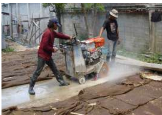
รูปที่ 6.54 หลังจากคอนกรีตแห้งสามารถถอดแบบและใช้เครื่องตัดจอยตัดถนน
