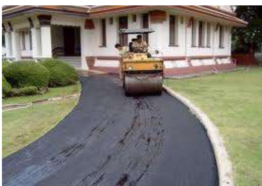
รูปที่ 6.48 การบดผิวแอสฟัลต์ให้เรียบโดย รถบด ซึ่งต้องมีน้ำหล่อผิวล้อเพื่อกันแอส ฟัลต์ติดล้อ
