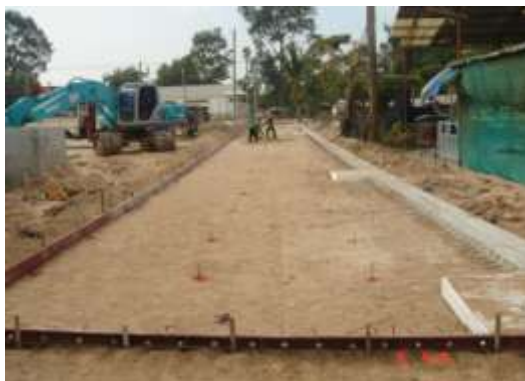
รูปที่ 6.50 การบดอัดดินต้องบดอัดให้ได้ตามที่ผู้ออกแบบได้ออกแบบไว้และมีผิวหน้าที่สม่ำเสมอ
