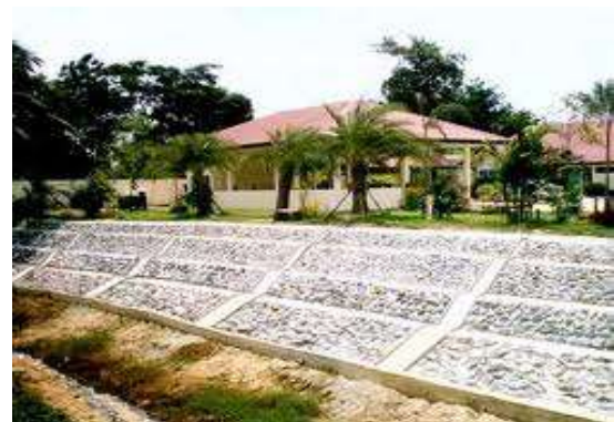
รูปที่ 6.65 เขื่อนลาดด้วยหินมีคานรัดตัดเป็นส่วนๆ เพื่อเพิ่มความแข็งแรง
