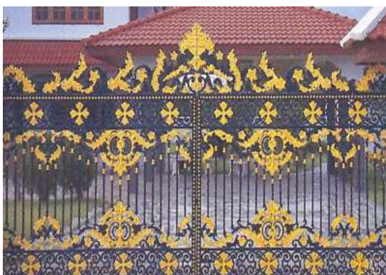
รูปที่ 6.9 ประตูรั้วโลหะอัลลอยเปิด-ปิดโดยการสวิง
