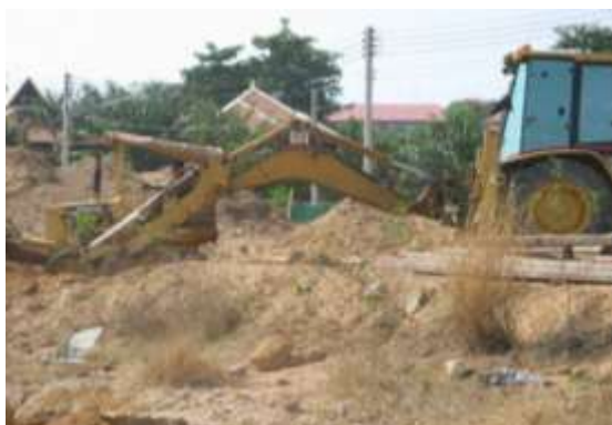
รูปที่ 2.1 แสดงการปรับพื้นที่บริเวณที่จะทำการก่อสร้าง โดยการกำจัดวัชพืชและวัตถุอื่นๆ ที่ไม่พึงประสงค์ก่อนงานก่อสร้าง
