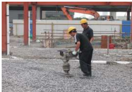
รูปที่ 2.9 การบดอัดดินด้วยคน ซึ่งใช้เครื่องบด อัดขนาดเล็ก บดอัดบริเวณภายในตัวอาคาร
