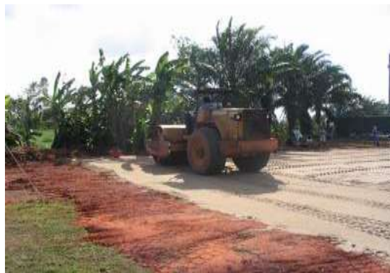
รูปที่ 2.7 ในบริเวณที่ดินยังมีหญ้าขึ้นอยู่ต้อง ขุดเปิดหน้าหลังจากนั้นจึงบดอัด
