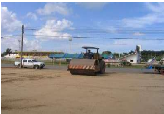
รูปที่ 2.8 ภาพถ่ายแสดงการใช้เครื่องบดอัด หน้าดิน
