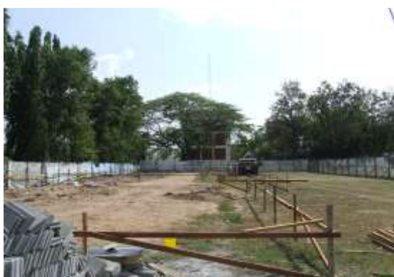
รูปที่ 2.18 การวางผังแนวเขตอาคาร ผังต้องม ีความแข็งแรง
