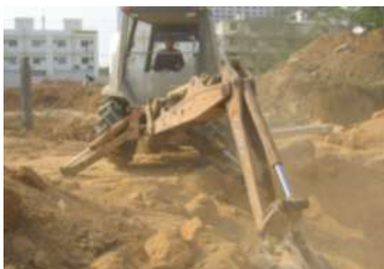
รูปที่ 2.3 แสดงการขุดดินโดยใช้รถขุดดิน ที่มีขนาดเหมาะสมกับพื้นที่ที่จะทำการขุดดิน
