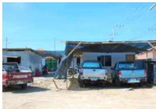
รูปที่ 2.12 แสดงอาคารสำนักงานชั่วคราวในหน่วยงานก่อสร้าง
