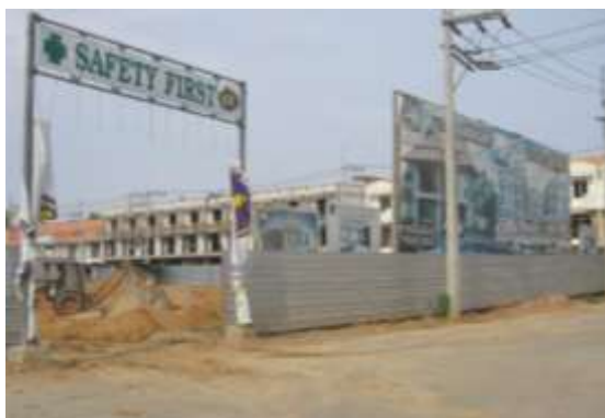
รูปที่ 2.11 แสดงการล้อมรั้วรอบบริเวณ ที่จะทำการก่อสร้างเพื่อป้องกันอันตรายที่จะเกิดขึ้น
