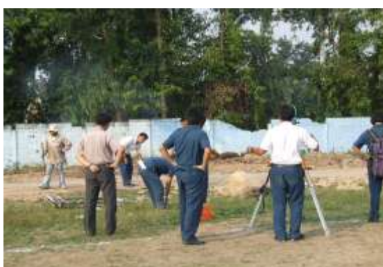
รูปที่ 2.16 การใช้กล้องวัดมุมทำผังเพื่อที่จะ กำหนดมุมหรือทำแนว
