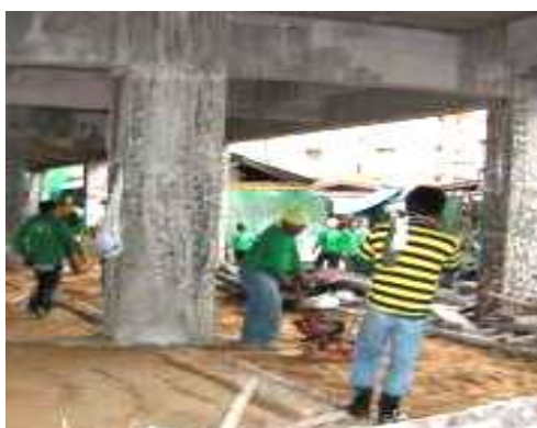
รูปที่ 2.10 การบดอัดดินด้วยเครื่องจักรขนาด เล็ก
