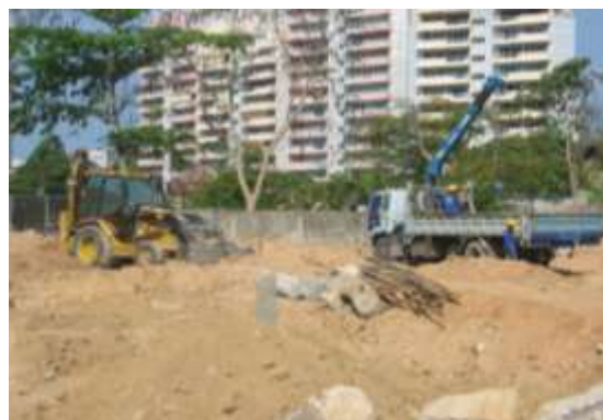
รูปที่ 2.2 แสดงการขนย้ายวัสดุที่ไม่เหมาะสมที่จะใช้ในงานถม ในบริเวณที่จะทำการก่อสร้าง ซึ่งผู้รับจ้างจะต้องนำวัสดุไปทิ้งใน ณ ตำแหน่งที่คณะกรรมการตรวจการจ้างกำหนด
