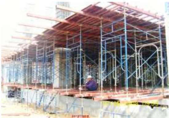
รูปที่ 2.24 การตั้งนั่งร้านชั้นล่าง
