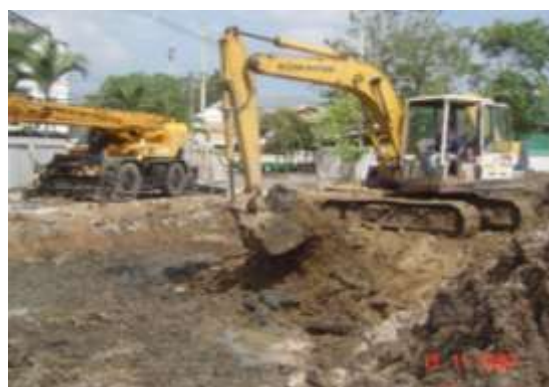
รูปที่ 2.5 แสดงงานขุดดิน
