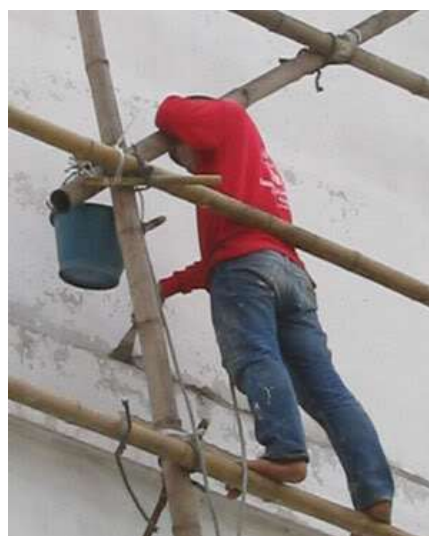
รูปที่ 2.27 แสดงนั่งร้านแบบไม้ไผ่
