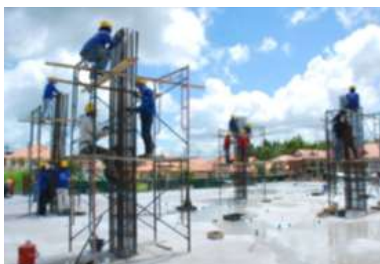
รูปที่ 2.20 แสดงการประกอบนั่งร้านเพื่อติดตั้งเสาเหล็ก
