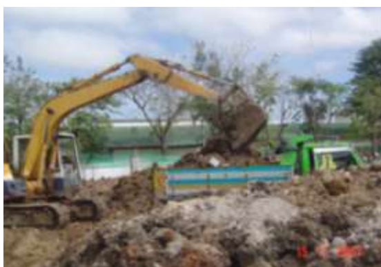
รูปที่ 2.4 แสดงงานขุดดินและงานขนย้ายดิน
