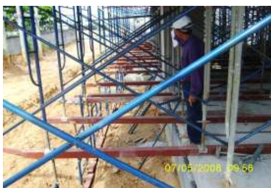
รูปที่ 2.22 รูปแสดงการตั้งค้ำยันรองรับแบบท้องพื้น
