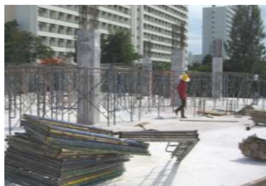
รูปที่ 2.21 แสดงการประกอบนั่งร้านเพื่อที่จะเทคอนกรีตชั้นบน
